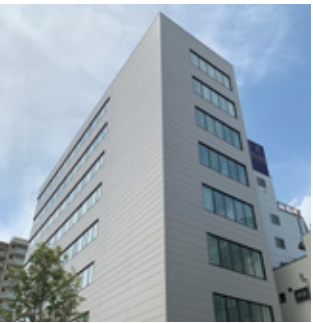
近鉄上本町石ヶ辻ビル
